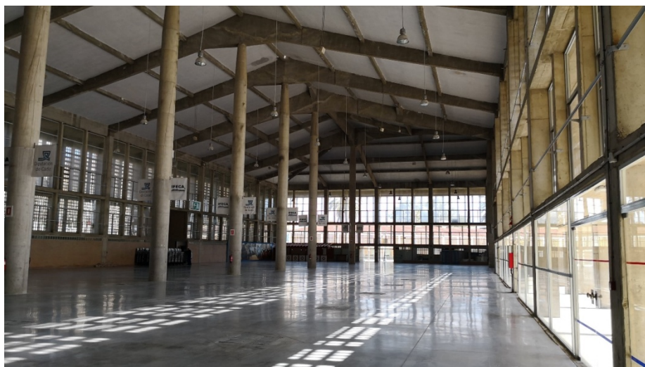
Fotografía del interior del pabellón.
