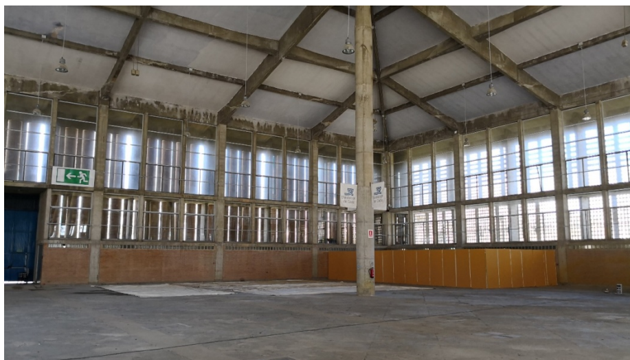
Fotografía del interior del pabellón.
