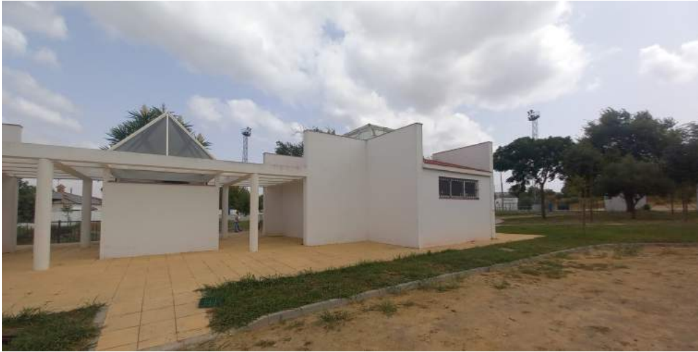
Vista de edificio auxiliar desde zona de juegos. Edificio formado por dos módulos simétricos y un espacio apergolado entre ambos que alberga las pilas lavadero y los fregaderos.
