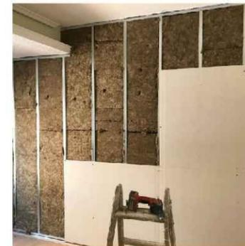
4º Placa Isoplac STD 15mm + Membrana ( Lamina MAD 4, danosa )+ placa Isoplac STD de 15mm
