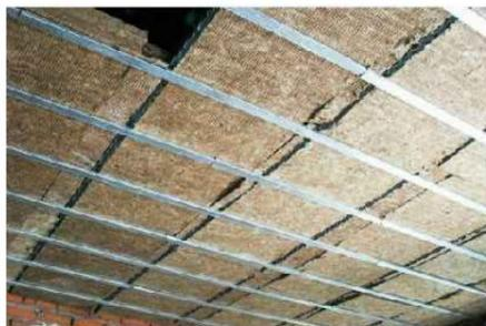
4º Placa Isoplac STD 13mm + Membrana ( Lamina MAD 4, danosa ) + Placa Isoplac STD 13mm
