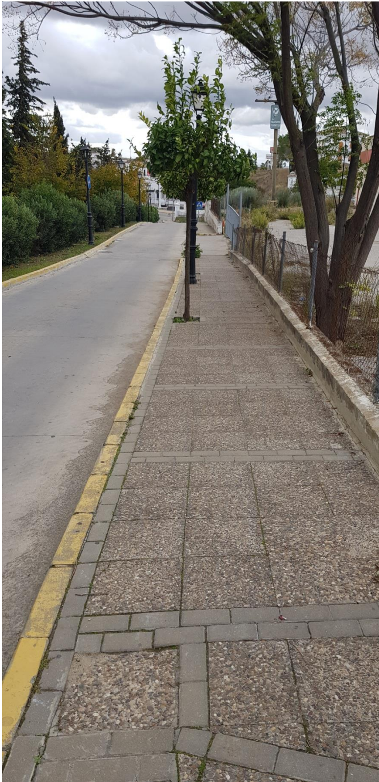
Fotografía 10 – Pavimento acerado existente
