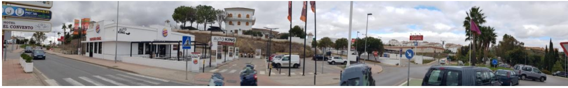
Fotografía 1 – Panorámica Rotonda Carretera 382
