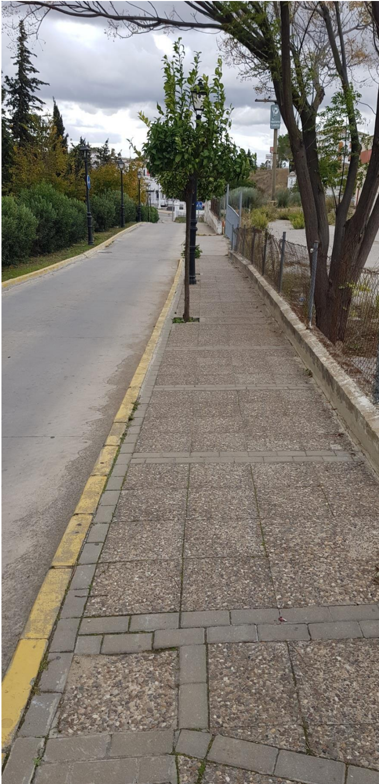
Fotografía 10 – Pavimento acerado existente
