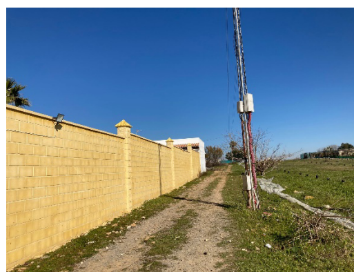
Vista desde el acceso Sur
