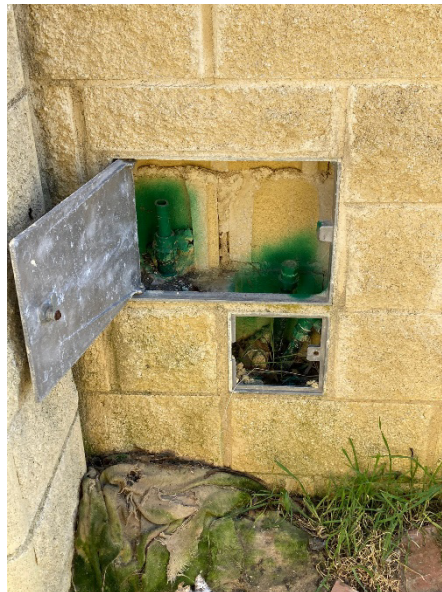
Acometida de aguas por el acceso Sur.
