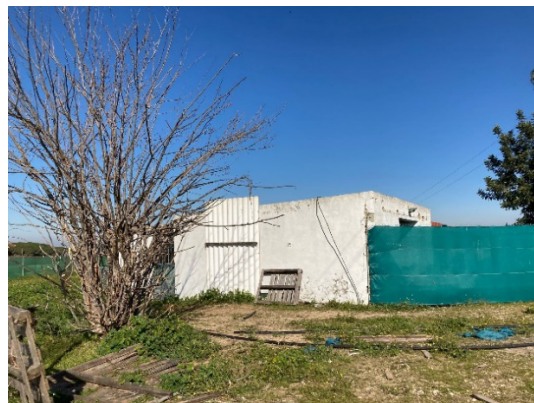
Construcción vista desde el Sur
