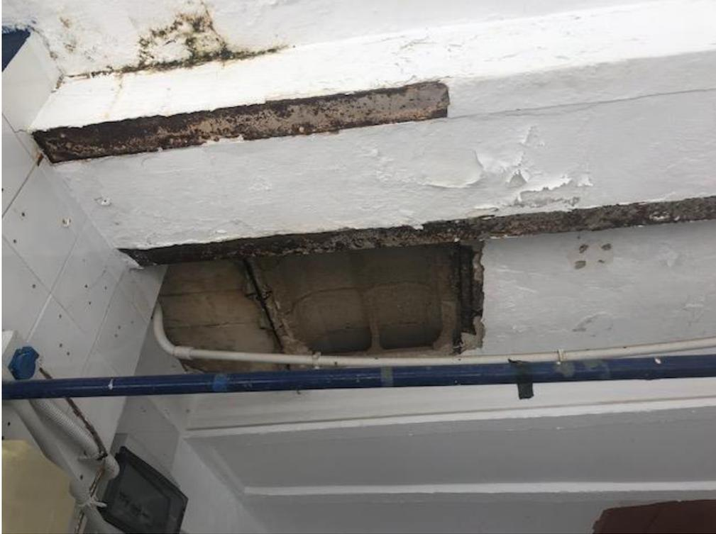
Vista de los puestos 56/57 con forjado con patologías estructurales
