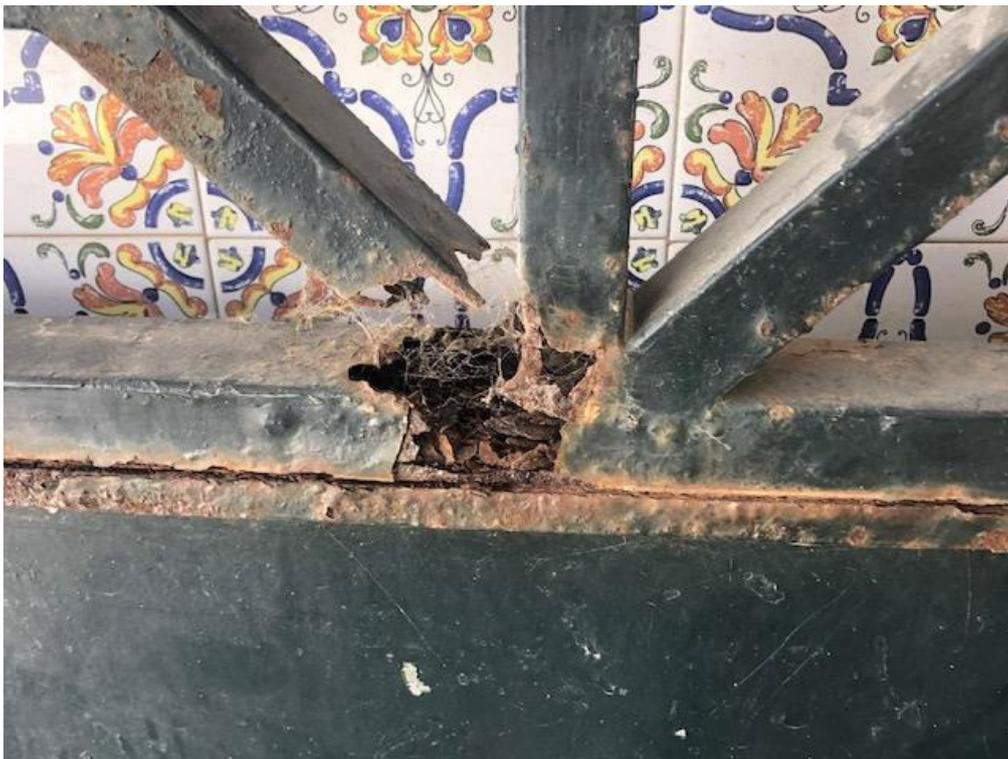
Vista de la oxidación de las puertas metálicas
