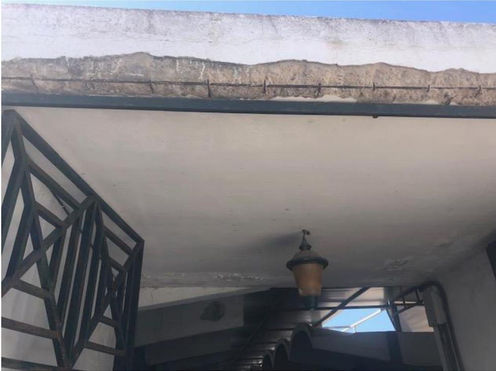
Vista de la viga cargadero en puerta de entrada con patologías estructurales
