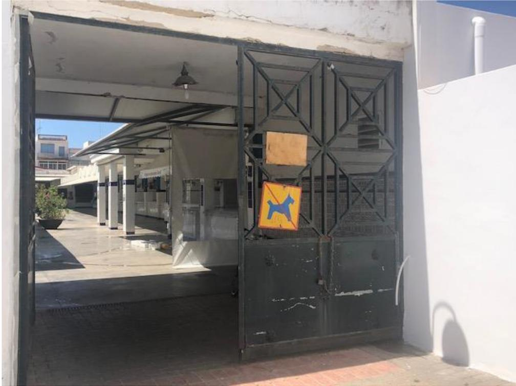
Vista de una de las puertas que se van a sustituir por mal estado de conservación
