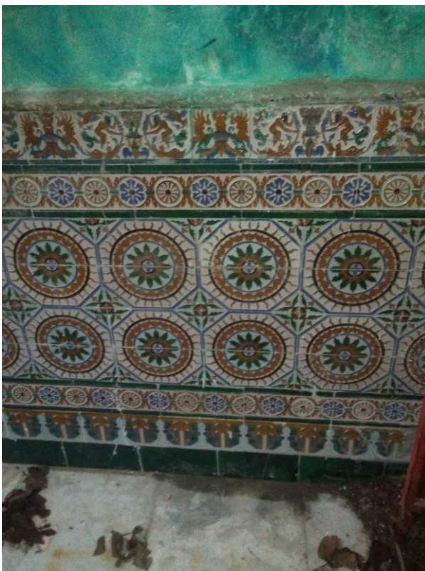
ZÓCALO INTERIOR DE AZULEJO SEVILLANO
