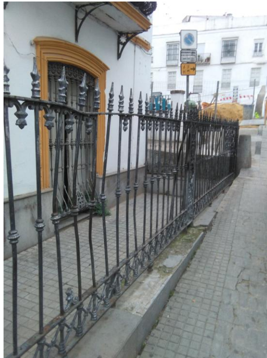
ENREJADO DEL PATIO EXTERIOR
