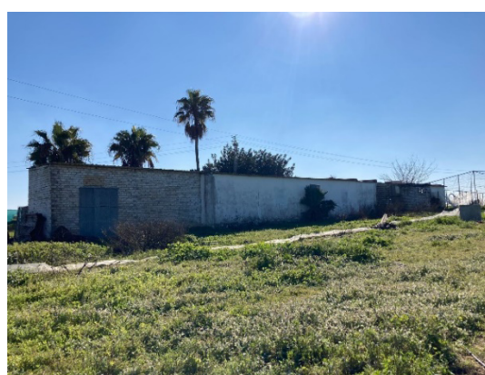
Construcción vista desde el Oeste
