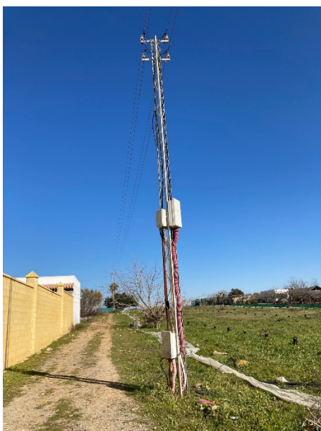
Bajada y soterramiento de la red, desde torre situada en la parcela.
