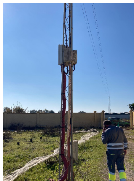
Bajada y soterramiento de la red, desde torre situada en la parcela.
