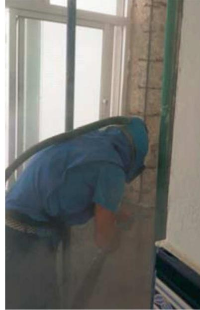
*Demolición del hormigón y limpieza de las armaduras mediante chorreo de arena.*
