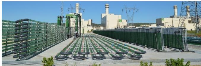
Ilustración 4. Vista general de la instalación de cultivo (fotobiorreactores)
