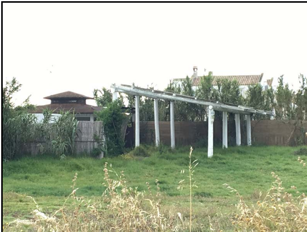
Foto 25: Vista lateral del Quiosco - Bar con Pérgola situados en la parcela 95 junto al Lindero Sureste con la parcela 96.
