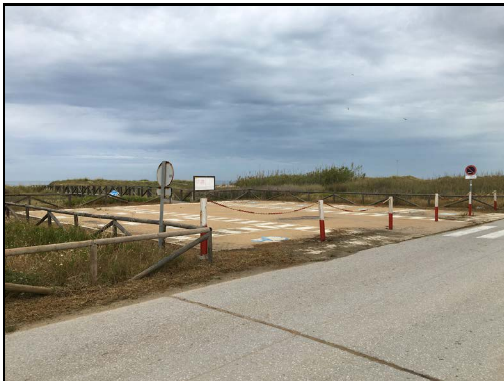
Foto 16: Vista desde la Carretera de El Palmar de aparcamientos para minusválidos y pasarela de acceso a la playa situados en el Suroeste de la parcela.
