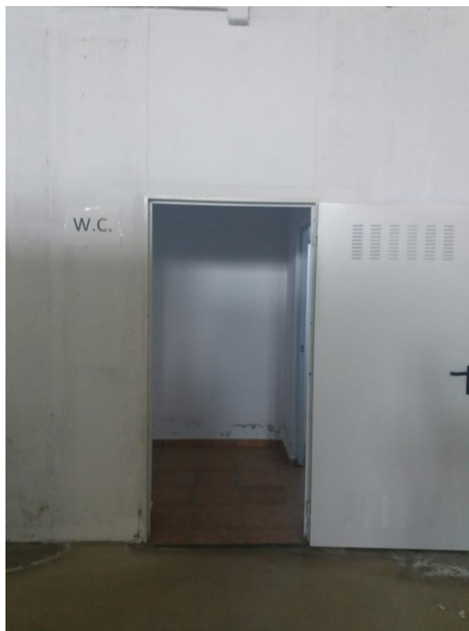
ACCESO DESDE EL INTERIOR DE LA NAVE MUNICIPAL
