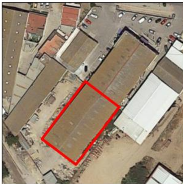
Nave sobre la que se actúa.
