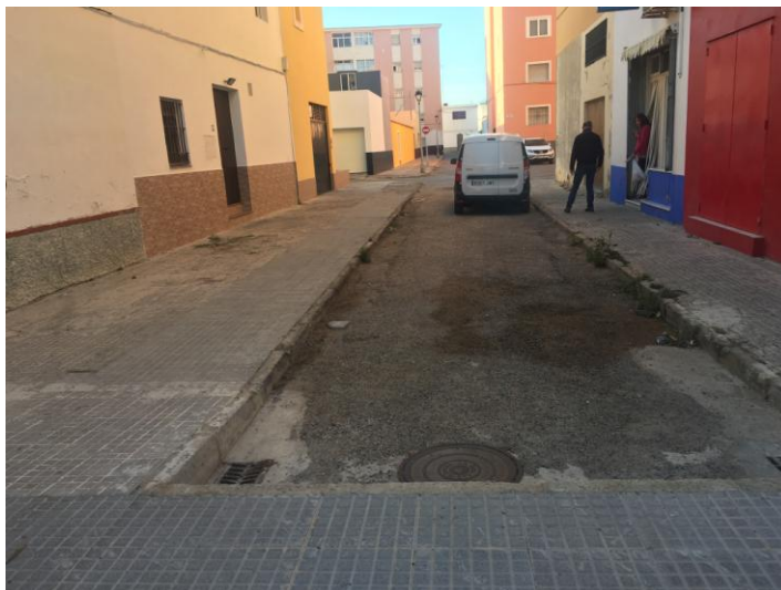
Vista general C/ Virgen del Carmen, mal estado acerado y pavimento, entre Avda. de Granada y C/ Virgen del Rosario
