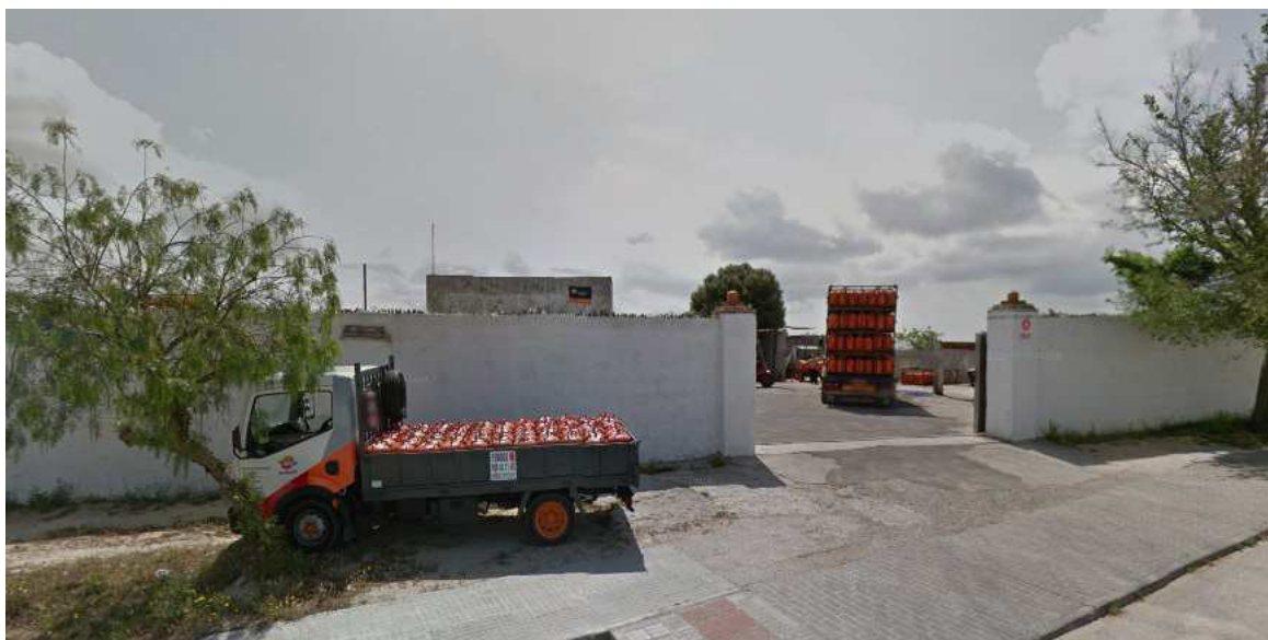
Almacén de bombonas de gas butano (al norte)
