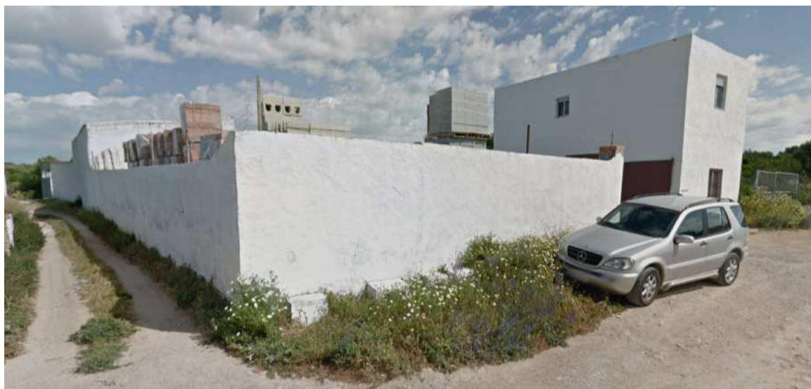
Almacén de construcción (al sur).
