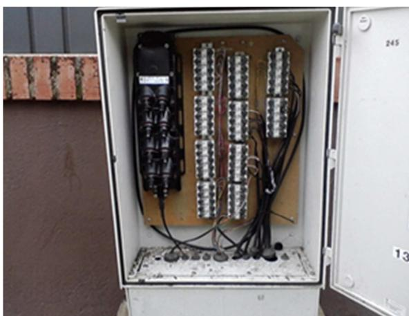
Ilustración 21. Caja terminal óptica (CTO) instalada en Pedestal
