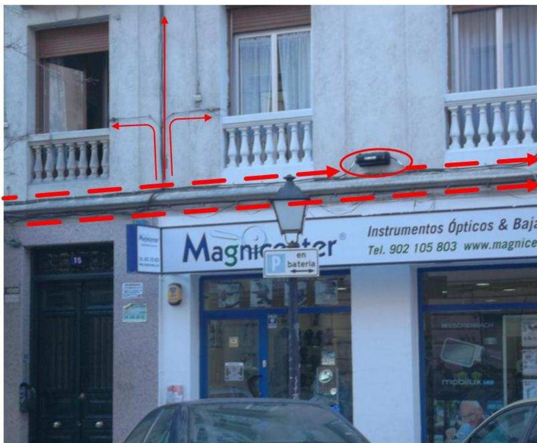
Ilustración 17. Trazado de cables por fachadas
