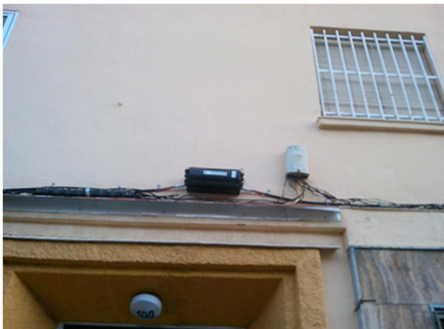
Ilustración 18. Caja terminal óptica (CTO) exterior
