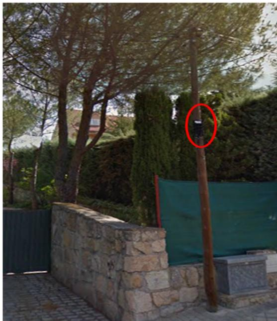
Ilustración 20. Caja terminal óptica (CTO) instalada en Poste
