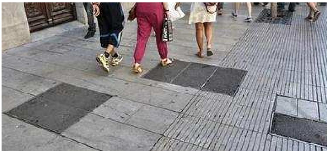
Ilustración 13. Arqueta de entrada a edificio con despliegue interior
